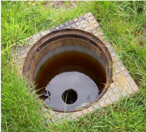
Figuur I-2 Verzamelput bij peilgestuurde drainage
